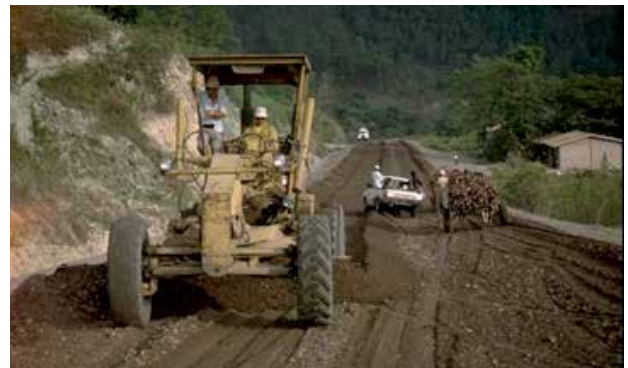
Trabajos de construcción de Carretera del Norte en Honduras. Fuente:TELEBÁSICA
