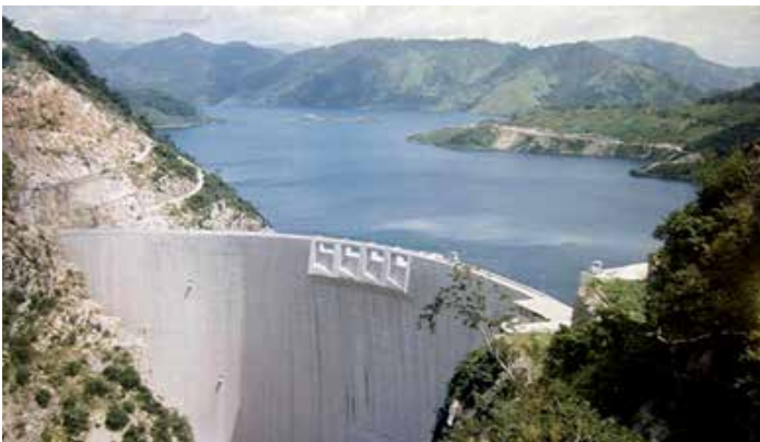
Cortina de la Represa Hidroeléctrica Francisco Morazán
