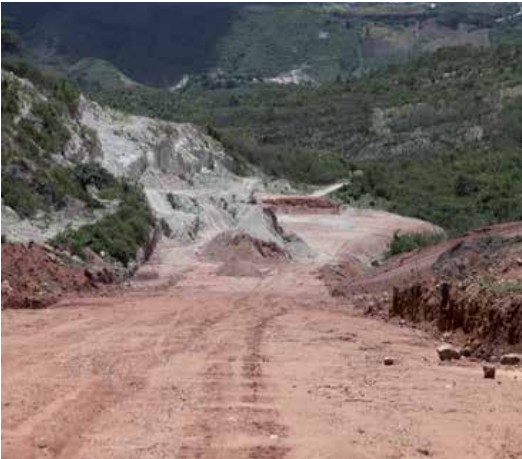
Remoción de tierra en la construcción de un proyecto habitacional en Tegucigalpa
