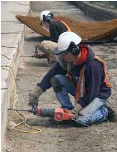
Equipo de protección personal, en trabajos de construcción
