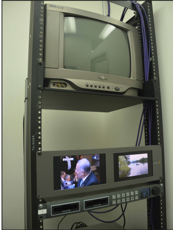
Equipo de recepción y reproducción de la señal satelital de TELEBÁSICA
