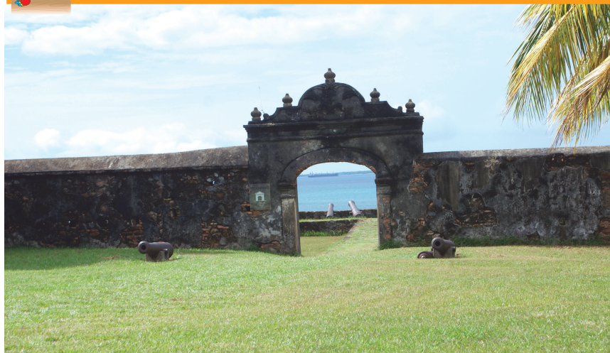
La Fortaleza de Santa Bárbara en Trujillo es parte de nuestro patrimonio cultural.
