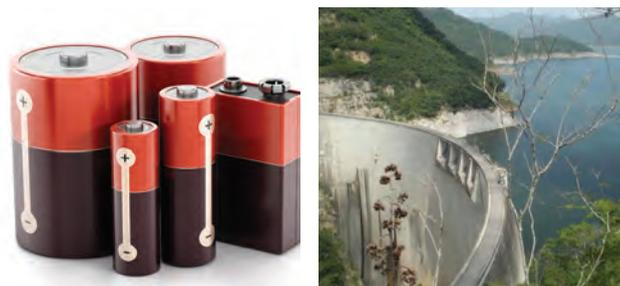
La corriente continua es generada por pilas y la alterna en centrales eléctricas como en la represa nacional Francisco Morazán "El Cajón"
